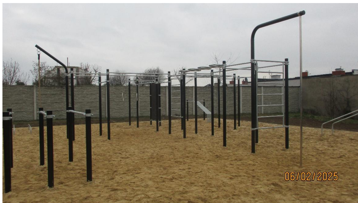
Budowa siłowni plenerowej Street Workout na os. Pożegowo.
